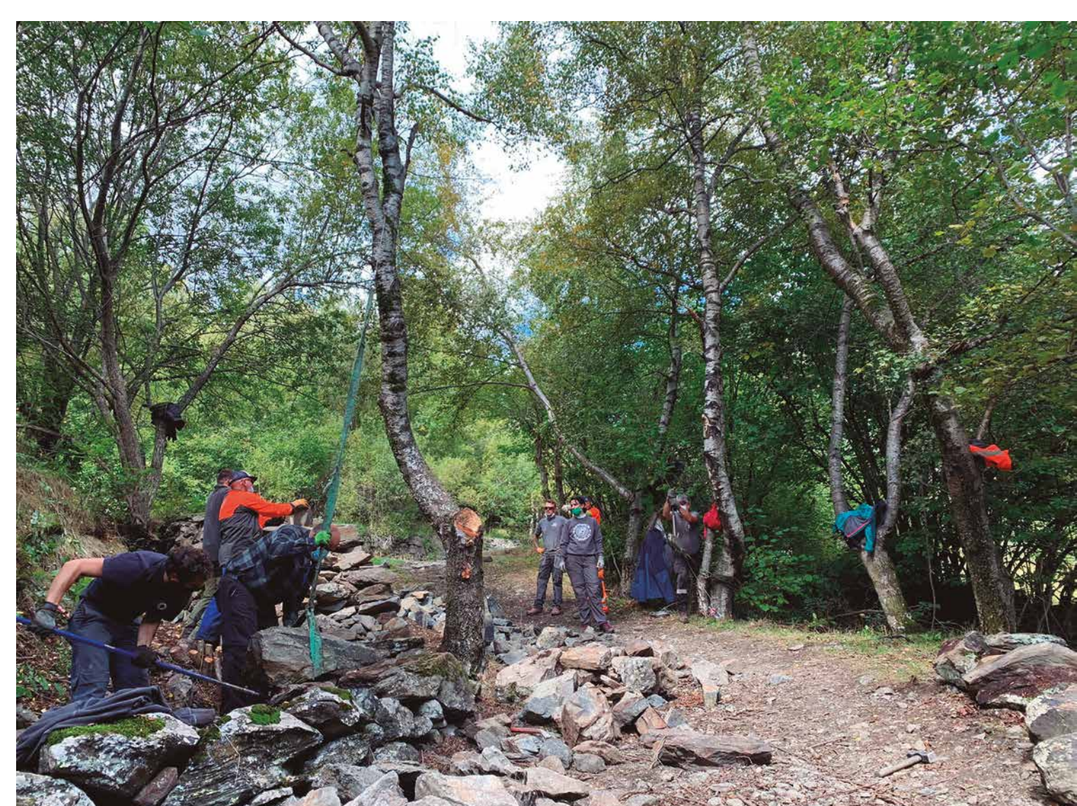
Construcció d'un mur de pedra seca
